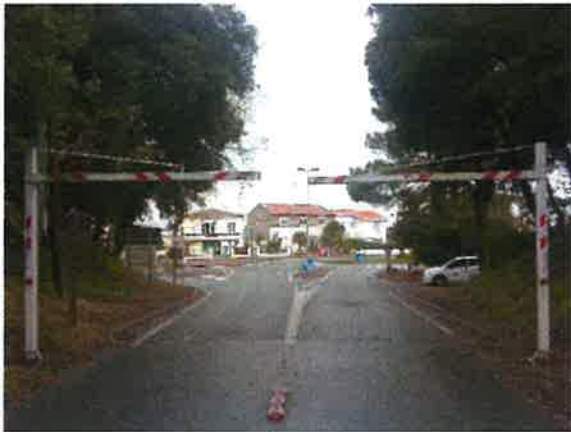
Portique métallique pivotant
