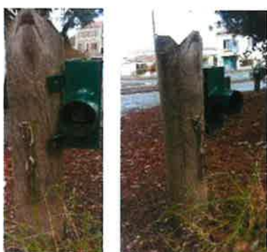
2 ème poteau avec découpe de l'empreinte de la lisse et système de fermeture
