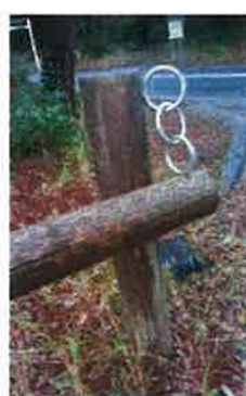
Fixation de la lisse au poteau par 3 anneaux
